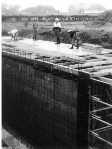
東北自動車道の工事 千駄野地内 (昭和45年7月)
