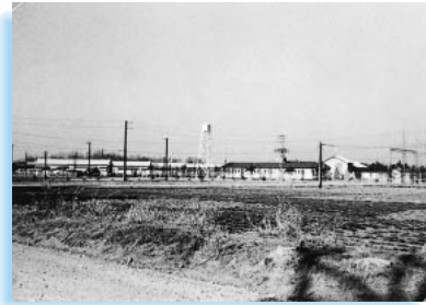
昭和35年 変電所社宅
